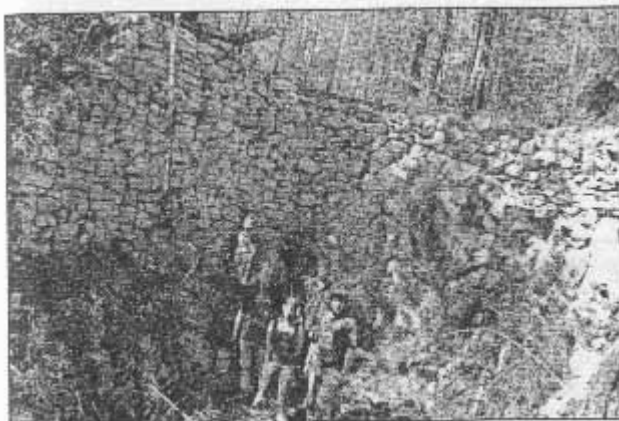
Осмотр "каменных мешков" под Златоустом (июль 2005)
